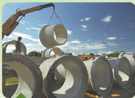
Mais de 300 ruas drenadas e saneadas
