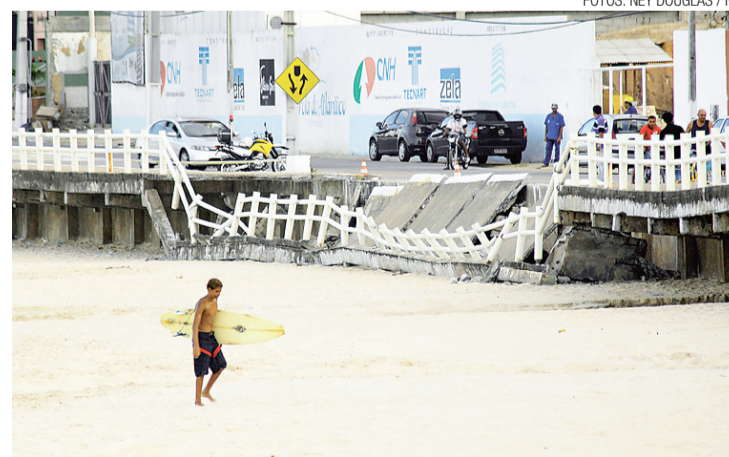
▶ Os vergalhões de ferro ficaram expostos e as colunas de cimento se partiram; segundo a Semsur, o motivo do desabamento pode ter sido a erosão
