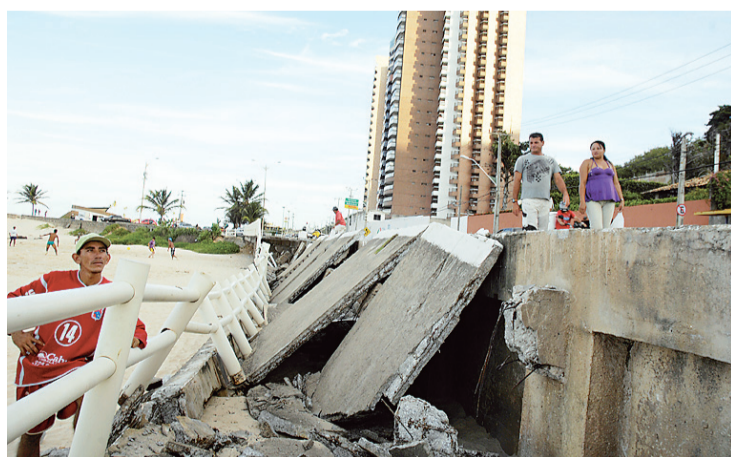
▶ Os vergalhões de ferro ficaram expostos e as colunas de cimento se partiram; segundo a Semsur, o motivo do desabamento pode ter sido a erosão
