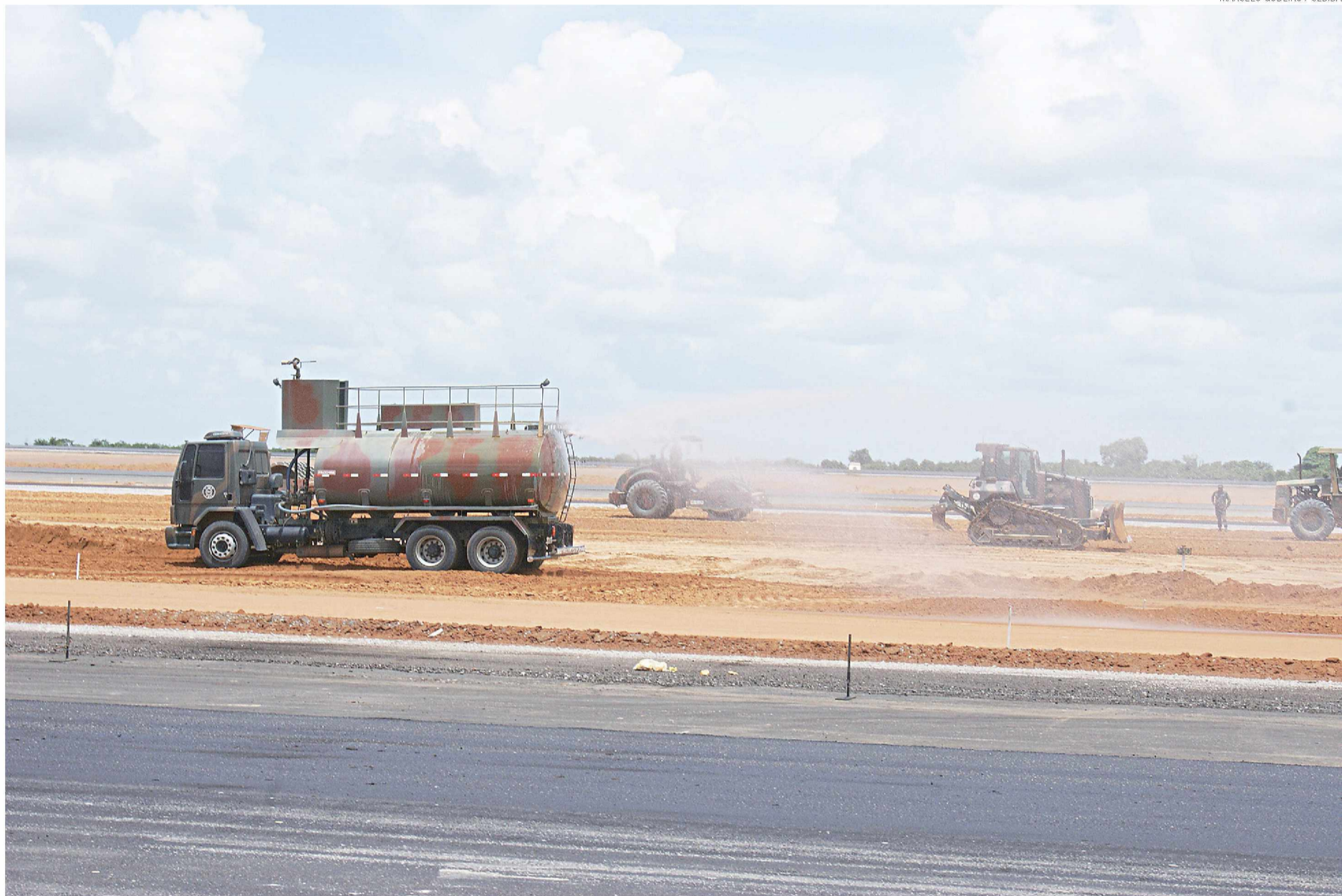
▶ Pista do aeroporto está sendo construída com recursos da Infraero
