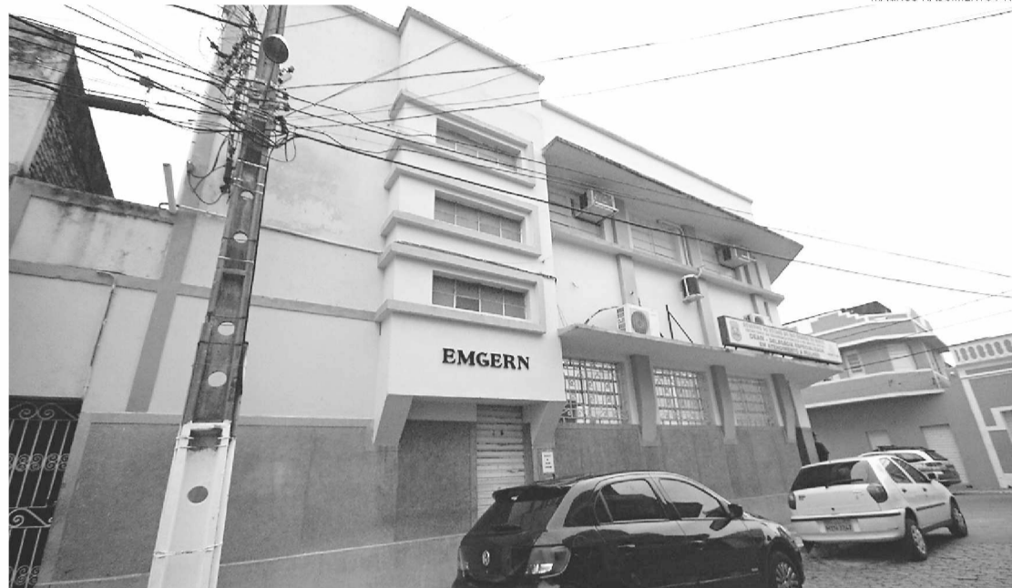
► Emgern funciona com 18 funcionários em um prédio na Ribeira
