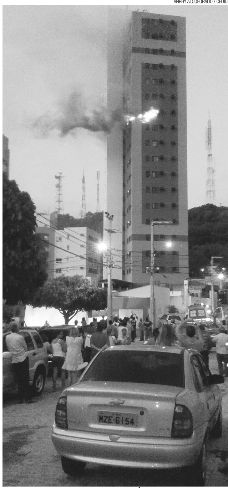
► Incêndio começou por volta de 17h45 na rua Ângelo Varela
