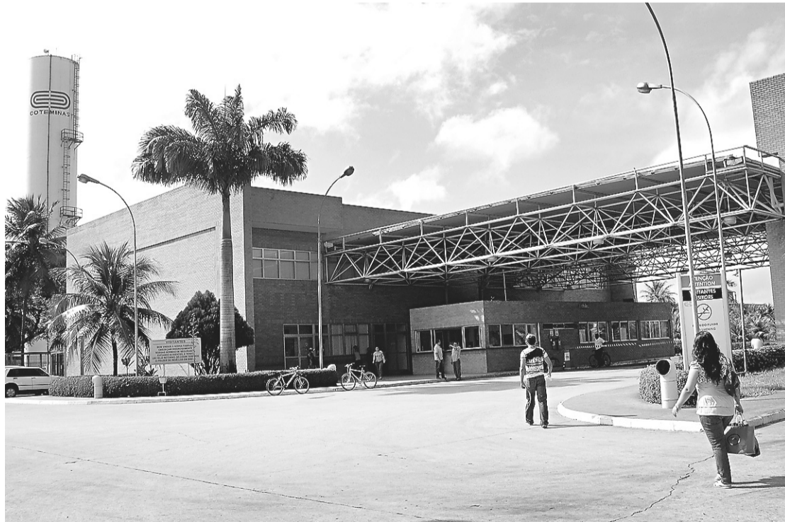
► Coteminas, em São Gonçalo do Amarante: assaltada
