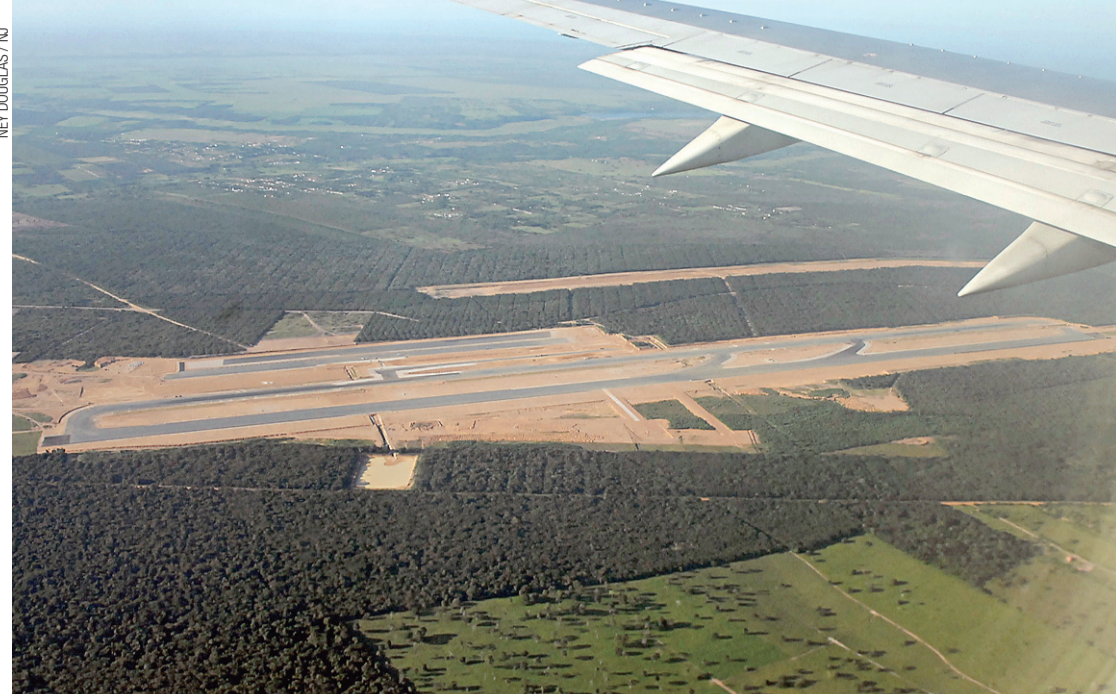
► Pistas do novo aeroporto são construídas pela Infraero
