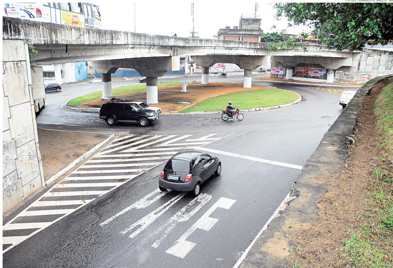
▶ Complexo da Urbana: obras contemplam a construção de um viaduto de 135 m de extensão e a organização dos acessos, com pista dupla e acessibilidade
