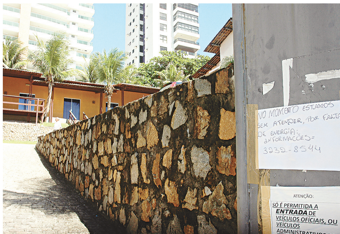
▶ ...do lado de fora, avisos sobre a falta de energia
