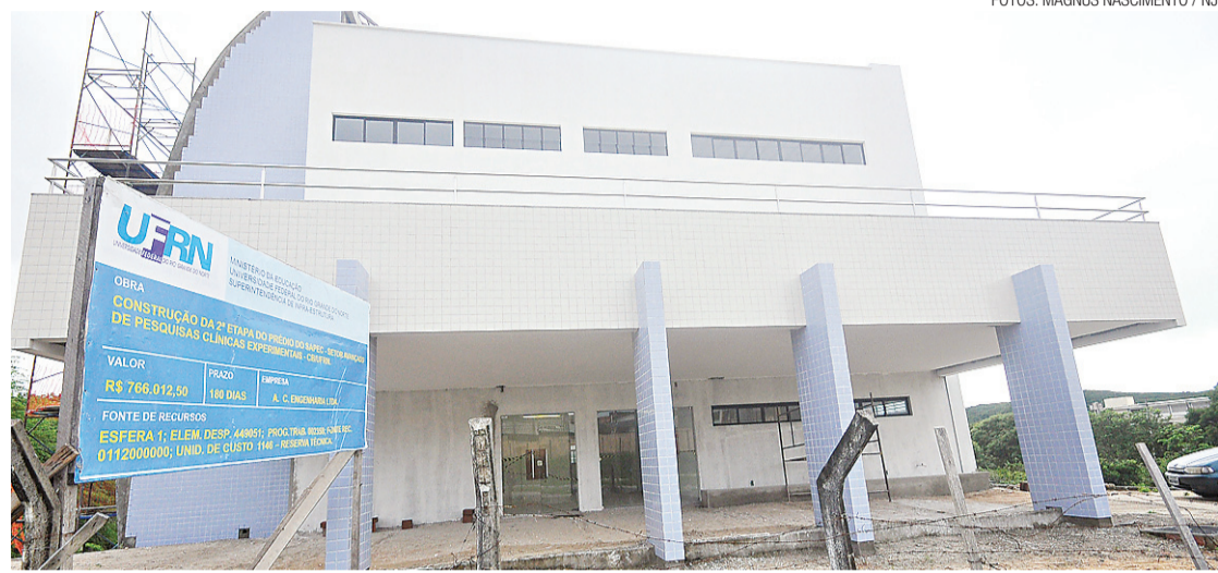
► Obras do Instituto de Medicina Tropical, na UFRN: conclusão prevista para outubro
