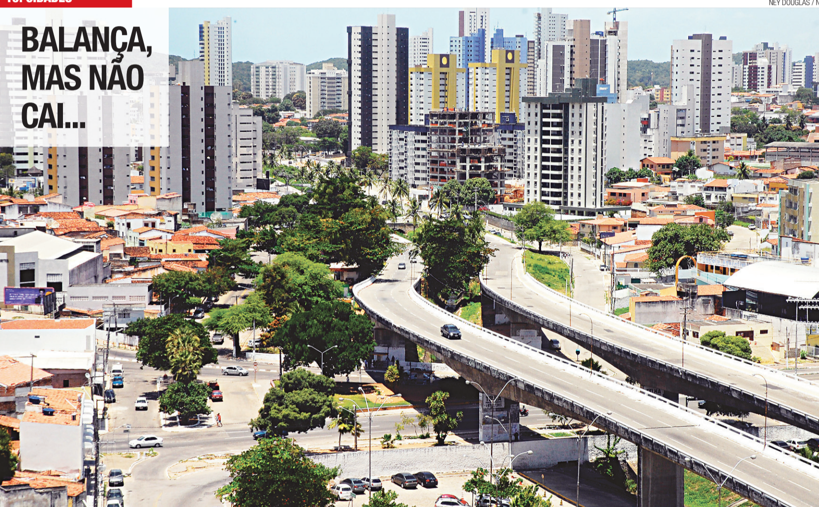
Tanto o CREA quanto a Semopi são enfáticos: o Viaduto do Baldo não corre risco de desabamento. Ação pedindo interdição baseou-se em documento de 2009
