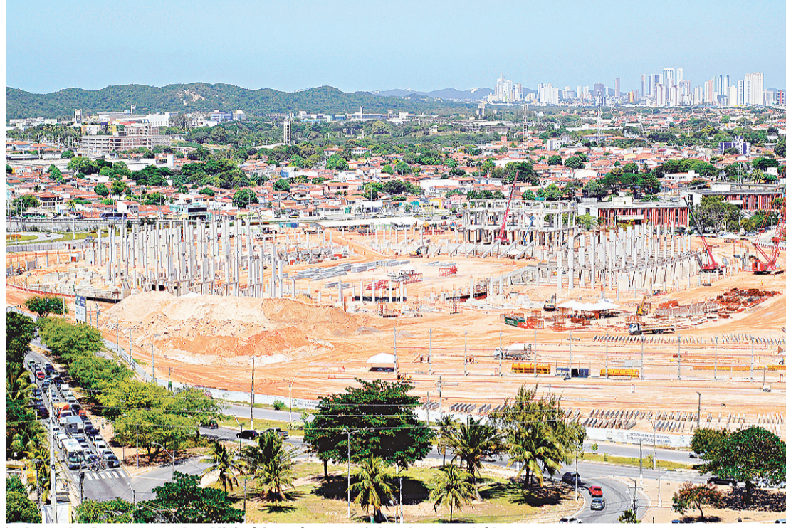
► Arena das Dunas, segundo o Ministério está com 30% das obras concluídas
