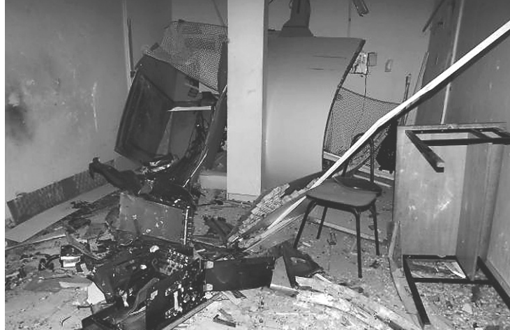
▶ Explosivos deixaram terminais bancários destruídos
