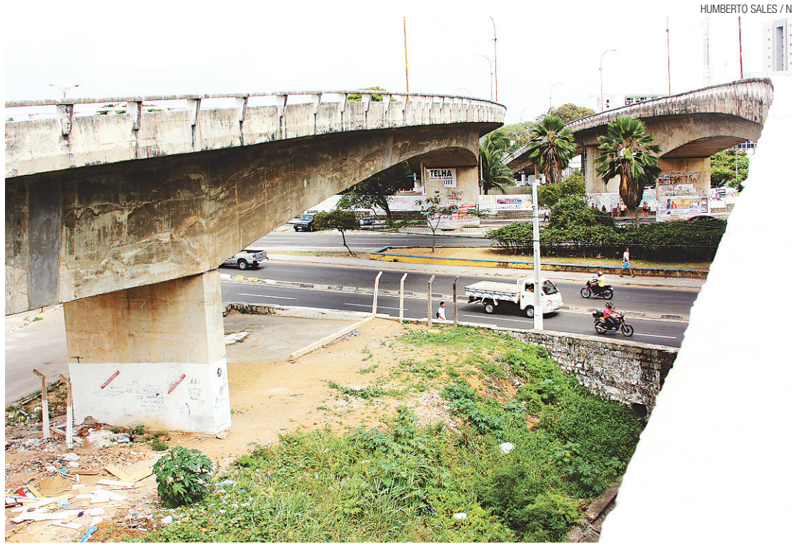
► Viaduto do Baldo: tráfego só por baixo do equipamento
