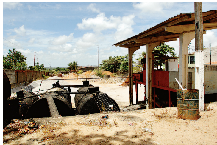
► Usina asfáltica chegou a produzir 60 toneladas de asfalto por mês
