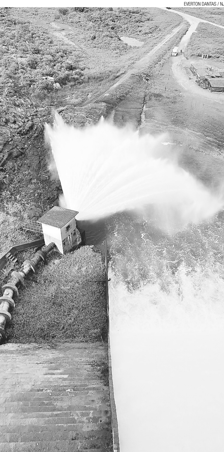
▶ Barragem de Santa Cruz, em Apodi, onde a gestão faz falta
