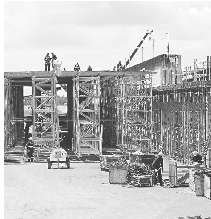
► O terminal de passageiros está na fase da superestrutura, 29% concluído
