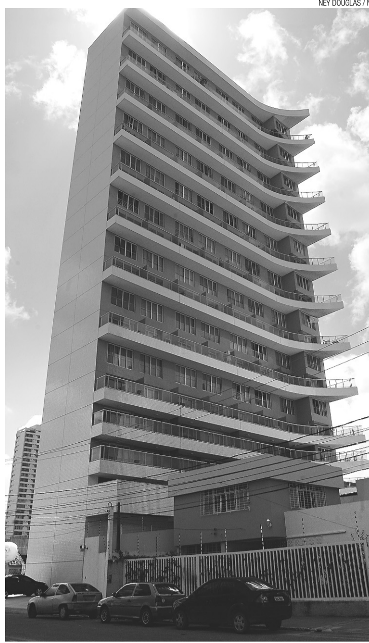
▶ Edifício Jardins do Alto, no bairro de Tirol: palco da tragédia
