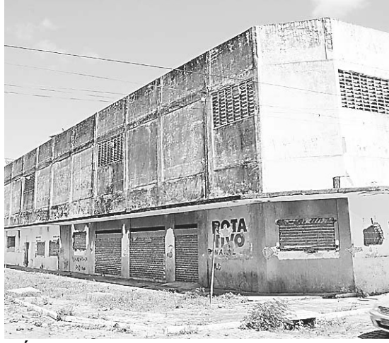
► Área prevista para a construção das unidades habitacionais
