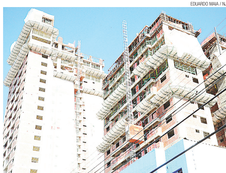
Construção Civil praticamente dobrou de tamanho nos últimos doze anos
