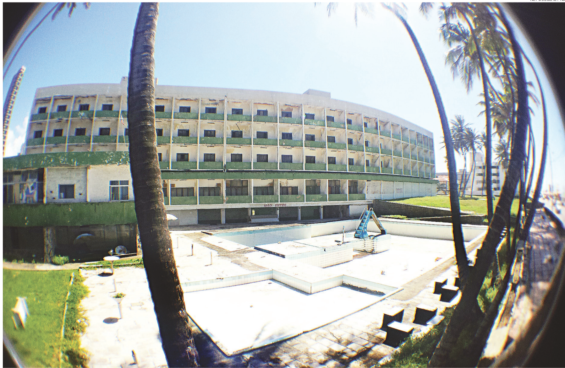
► Semob, Covisa e Semurb já foram acionadas para promover análises do prédio visando acabar com o "outdoor negativo" que o local representa para a cidade
