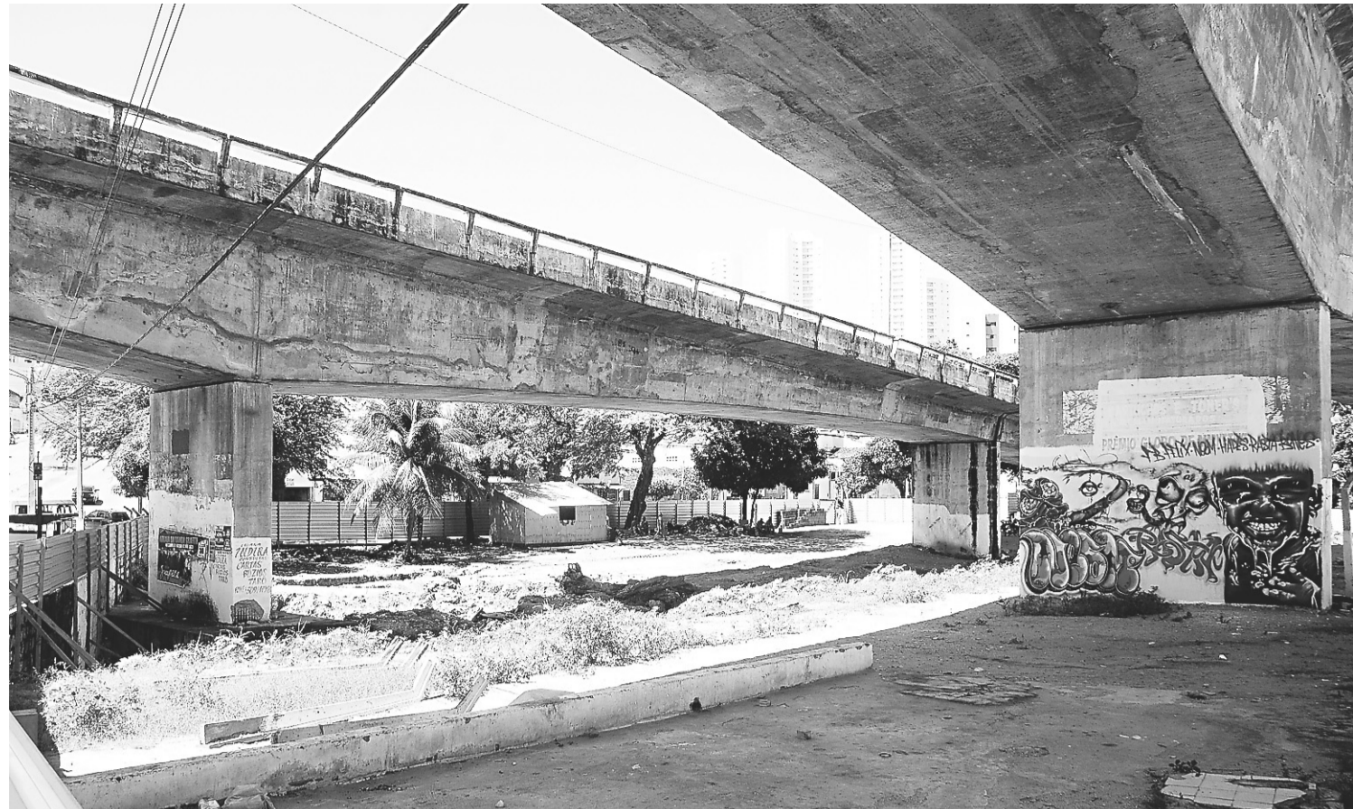
▶ Canteiro de obras do Viaduto do Baldo: operários capinaram o local e limpam a fuligem da parte de baixo da estrutura de concreto
