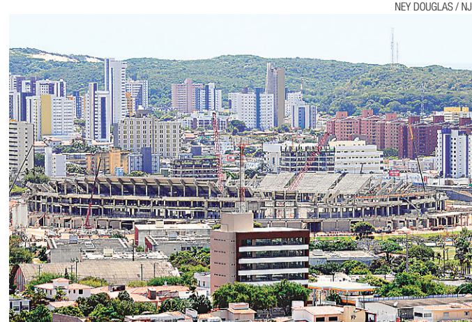
▶ Estádio em Lagoa Nova está em fase de conclusão
