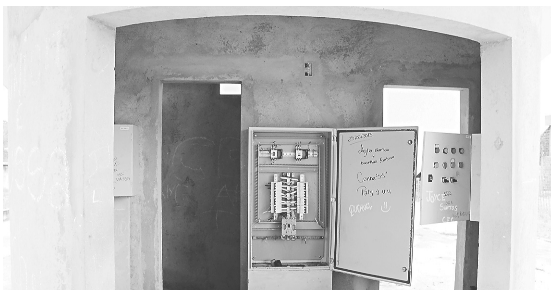
► Abandonado há mais de quatro anos, o parque está com a estrutura comprometida
