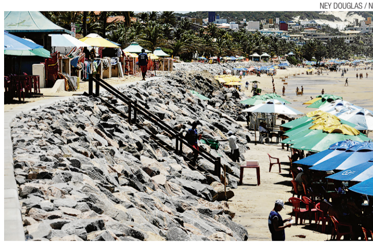
▶ Obra de enrocamento do calçadão de Ponta Negra: 75% concluída
