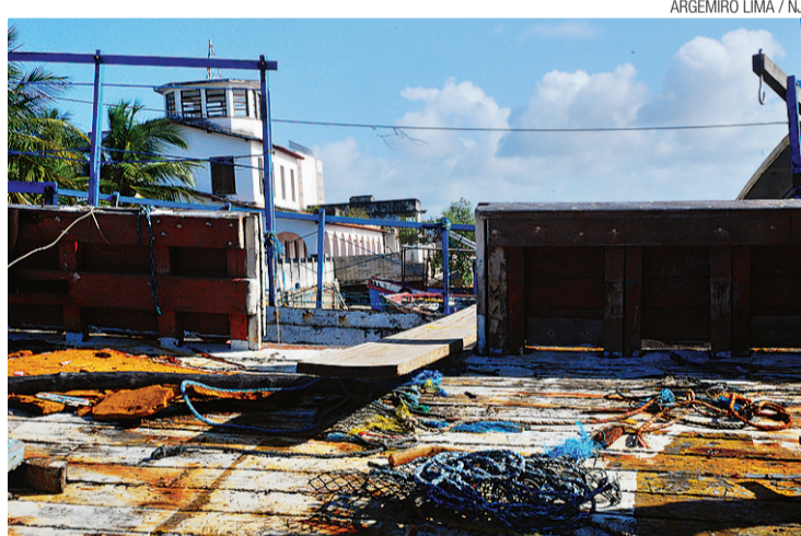
▶ Acesso de pessoas estranhas atrapalha obra do Complexo da Rampa
