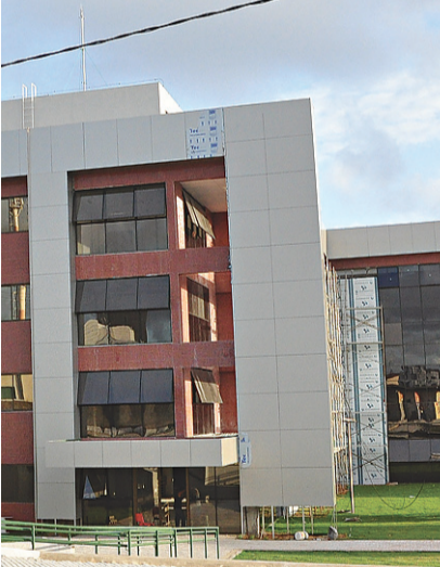
► Sede do IMD, ainda em construção
