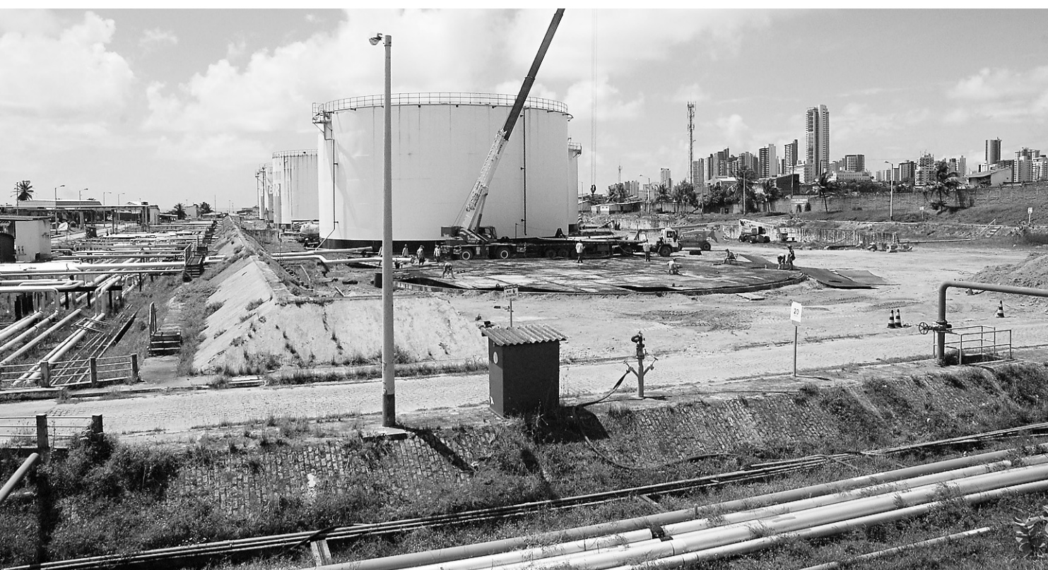
Reservatórios foram instalados no bairro no fim da década de 40 e começaram a ser desmontadas em julho; ontem, operários e guindastes trabalhavam no local
