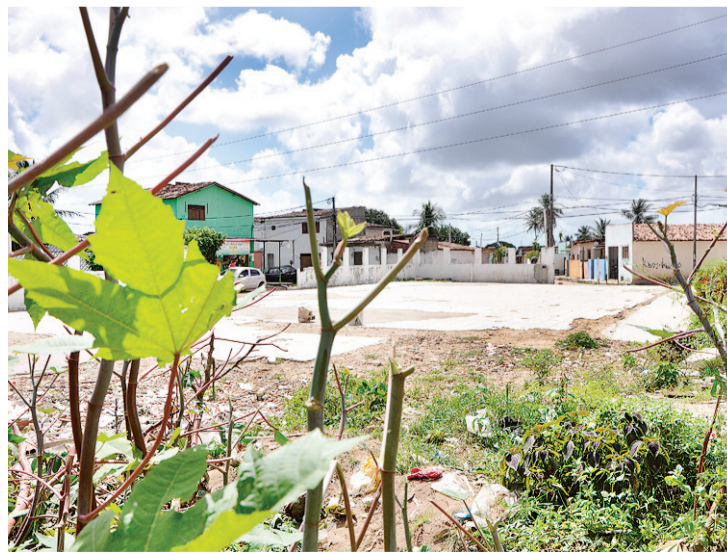
► Igreja demolida depois que desabou ainda não foi reconstruída
