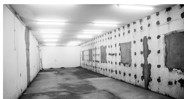
► Reforma da sala que vai abrigar o acervo do Diário de Natal
