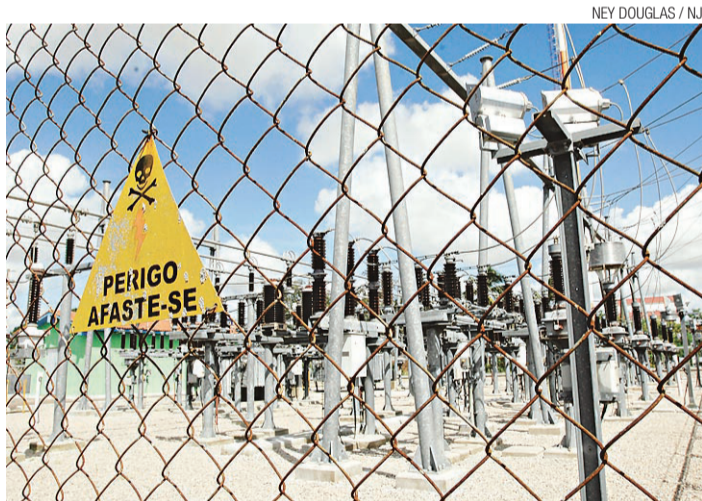
► Usina termoeletrica Potiguar II, em Macaíba: reforço no sistema elétrico
