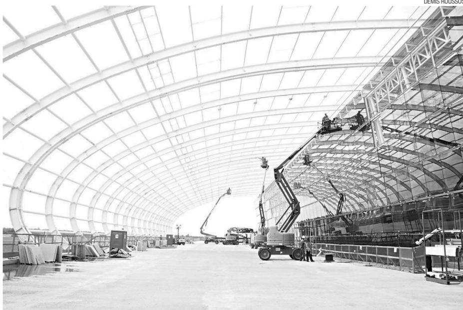
Operários fixam painéis de vidro na cobertura do terminal, que tem formato de uma asa de avião
