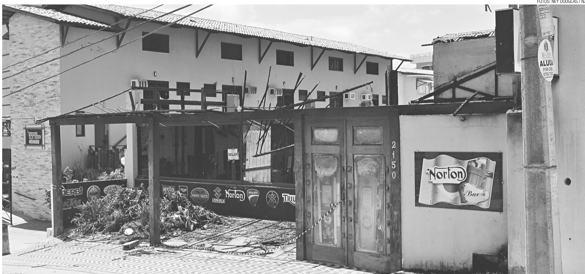
► Norton Bar, situado na Rua da Salsa, em Ponta Negra, pegou fogo na semana passada: fechado há dois anos, empreendimento estava com o Atestado de Vistoria do Corpo de Bombeiros vencido
