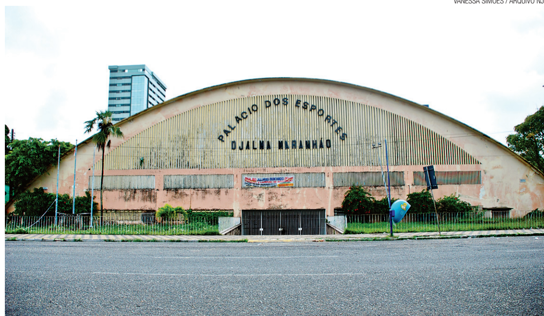
► Palácio dos Esportes, em Petrópolis: investimento de R$ 1,5 milhão na reforma
