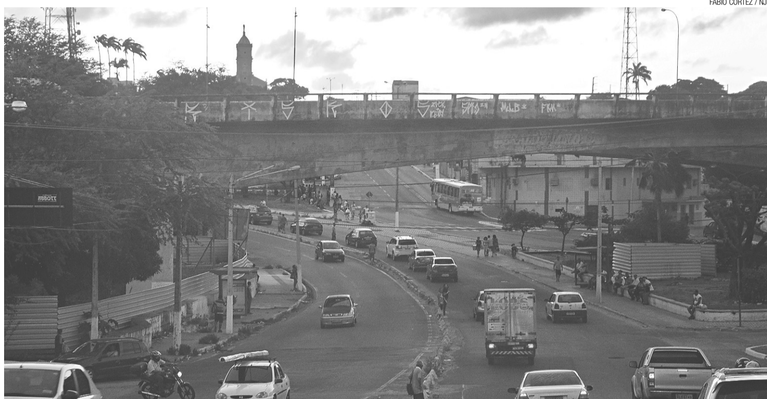
Complexo do Viaduto do Baldo tem custo de recuperação ampliado em quase 90% e interdição pode provocar caos no trânsito
