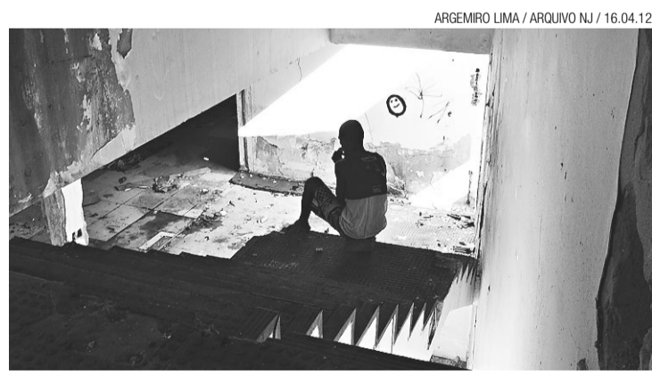
▶ Abandono do prédio da Semurb é alvo de inquérito do MP
