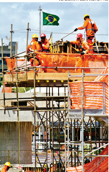
▶ Obras de mobilidade, no entorno da Arena das Dunas, empregam atualmente 922 pessoas
