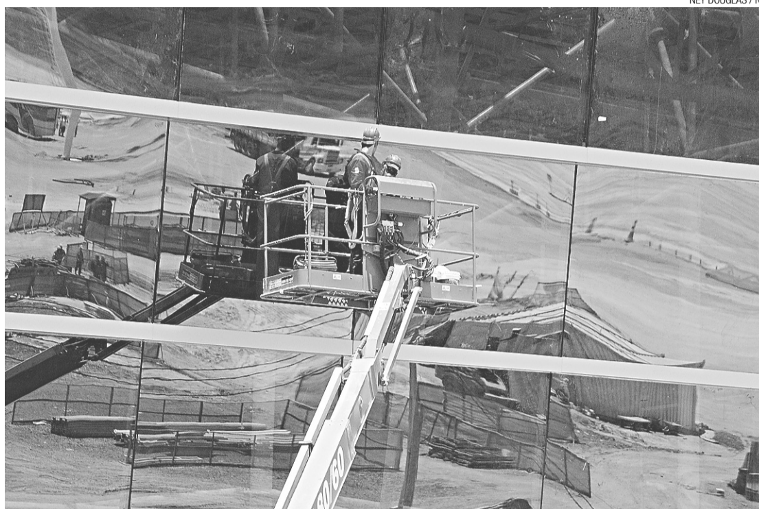
Trabalhadores instalam fachada do Aeroporto Aluizio Alves; empreendimento refletiu no chamado Vetur Norte
