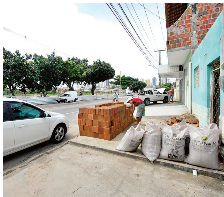
▶ Moradores reformam casas após alagamentos da lagoa de São Conrado
