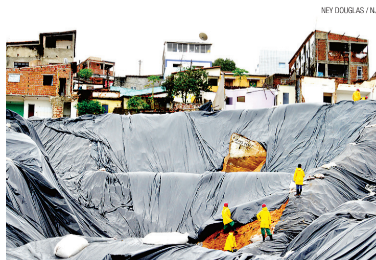
► Encosta está toda protegida para evitar novos deslizamentos
