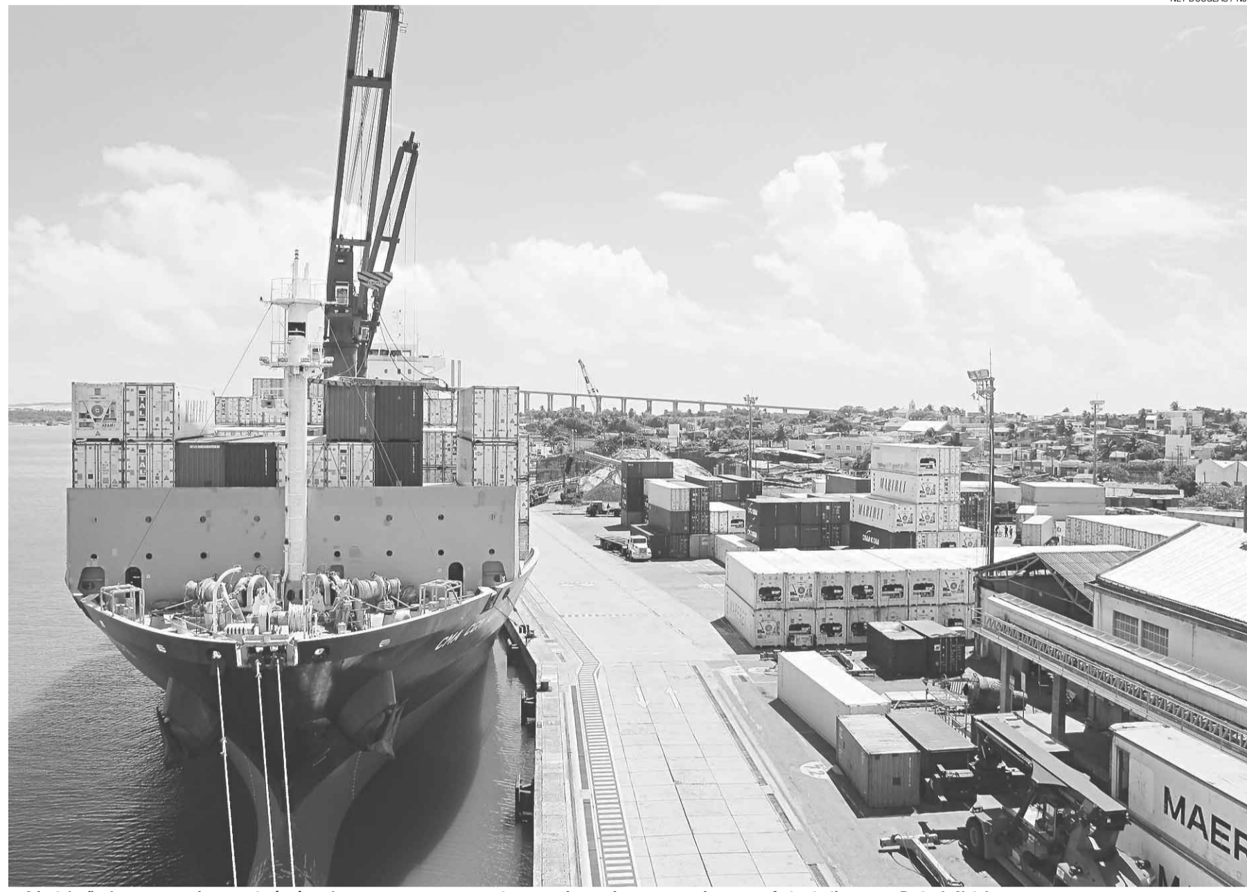
► A instalação de um novo cais aumentará a área de ancoragem para comportar cargueiros maiores, o que vai gerar um forte atrativo para o Porto de Natal
