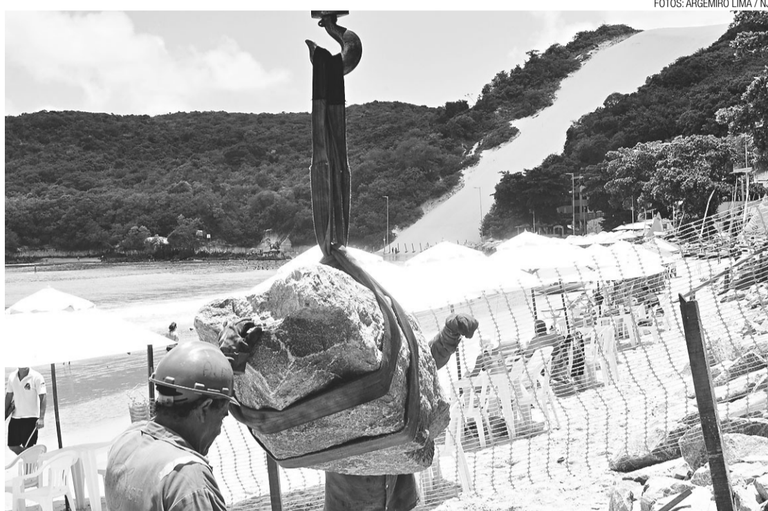
► Pesagem das pedras feita por equipe de engenharia da UFRN aponta divergência entre serviço executado e projetado
