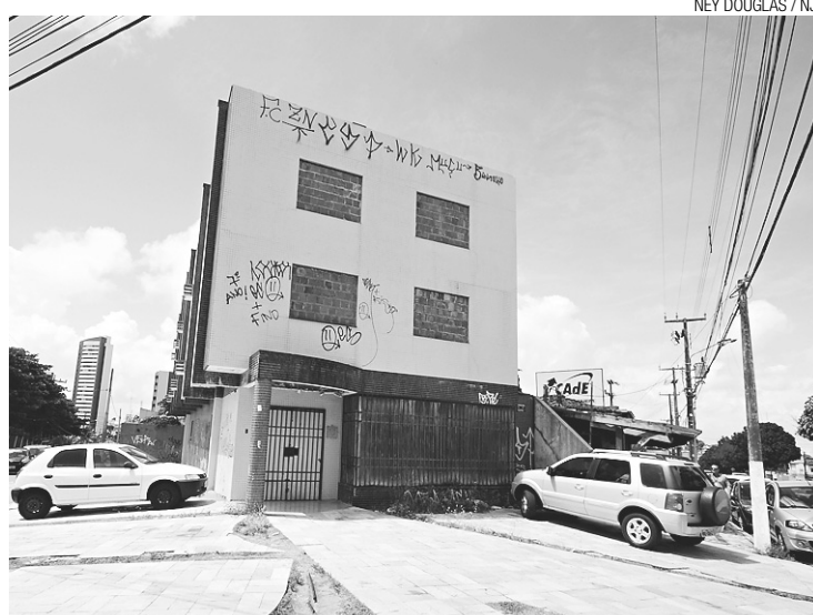
► Imóvel do MPE que será demolido
