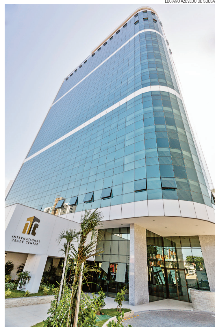
▶ A fachada em pele de vidro do ITC se destaca em meio à paisagem local
