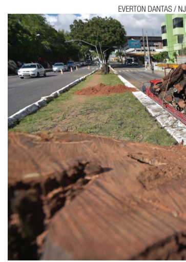
► Canteiro da Avenida Salgado Filho
