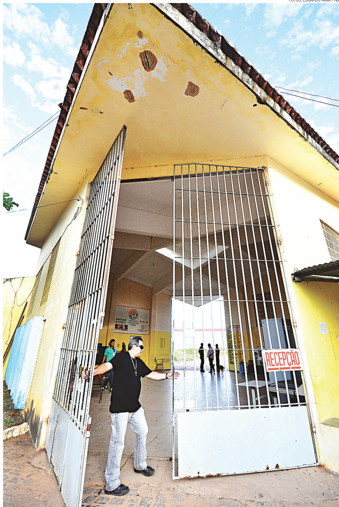
► Penitenciária Estadual de Alcaçuz: imprensa não teve acesso ao Pavilhão 4, cuja reforma foi concluída
