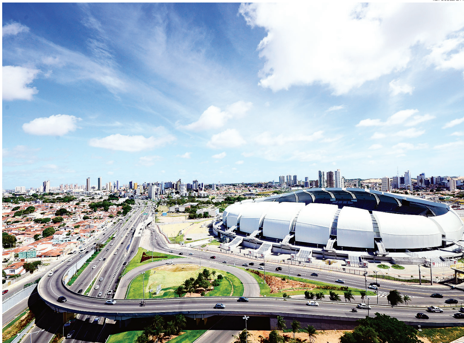
► Conjunto de túneis e viadutos do Complexo Viário Dom Eugênio Sales, no entorno da Arena das Dunas, está entre as obras concluídas pela Prefeitura de Natal
