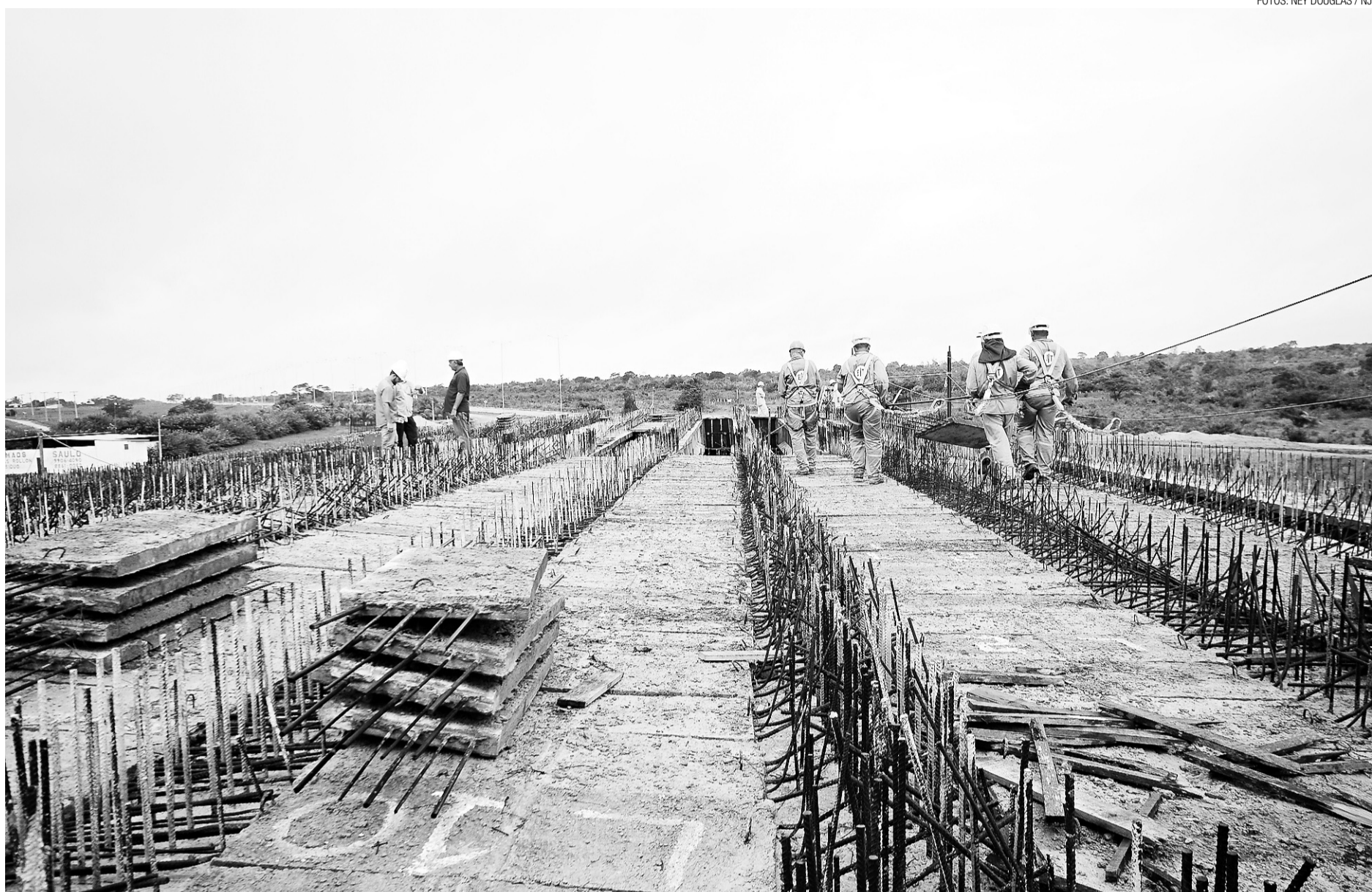
► Conclusão de acessos é uma das condições para que hub seja instalado no RN, detalhe motivou Governo a agilizar obra com recursos próprios
