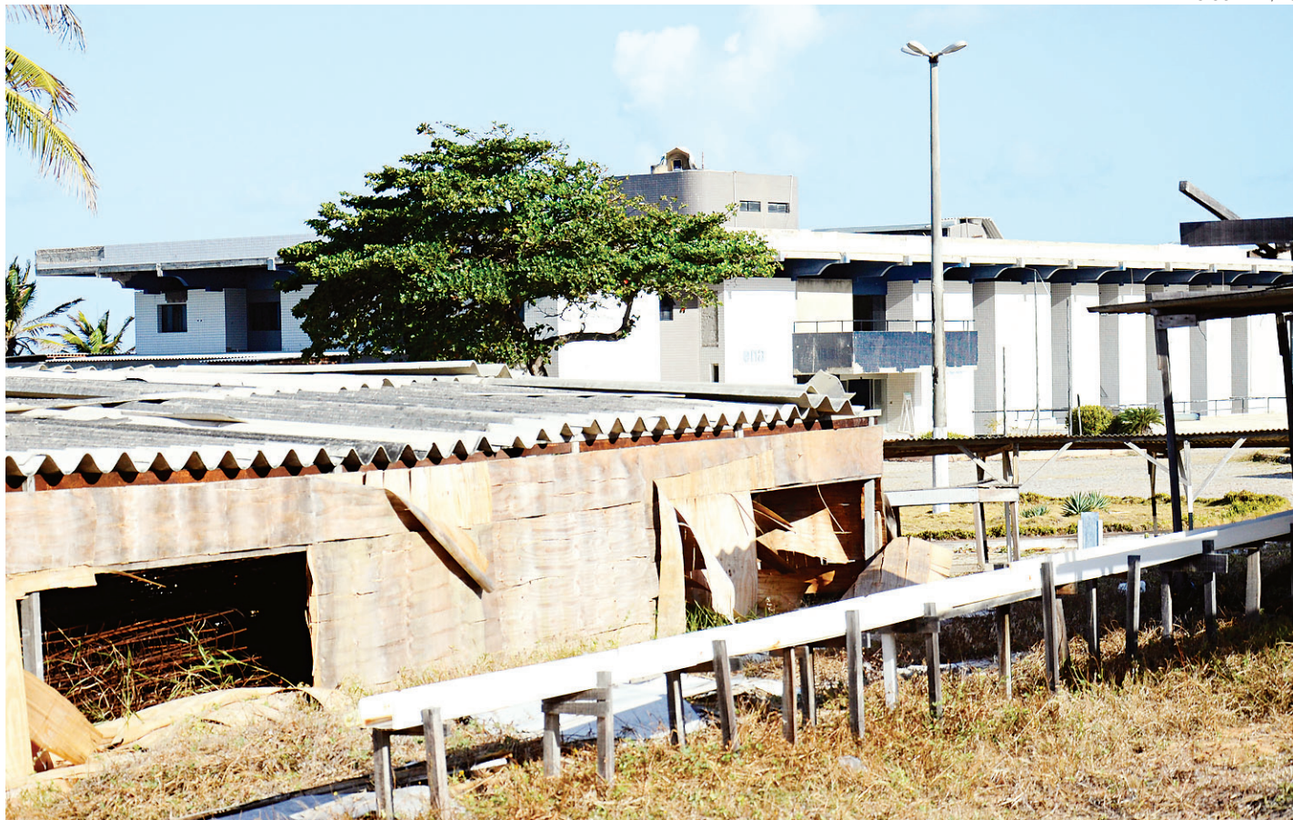
// Entulhos da obra iniciada em fevereiro de 2013 e que deveria ter ficado pronta há mais de um ano se acumulam ao longo do terreno
