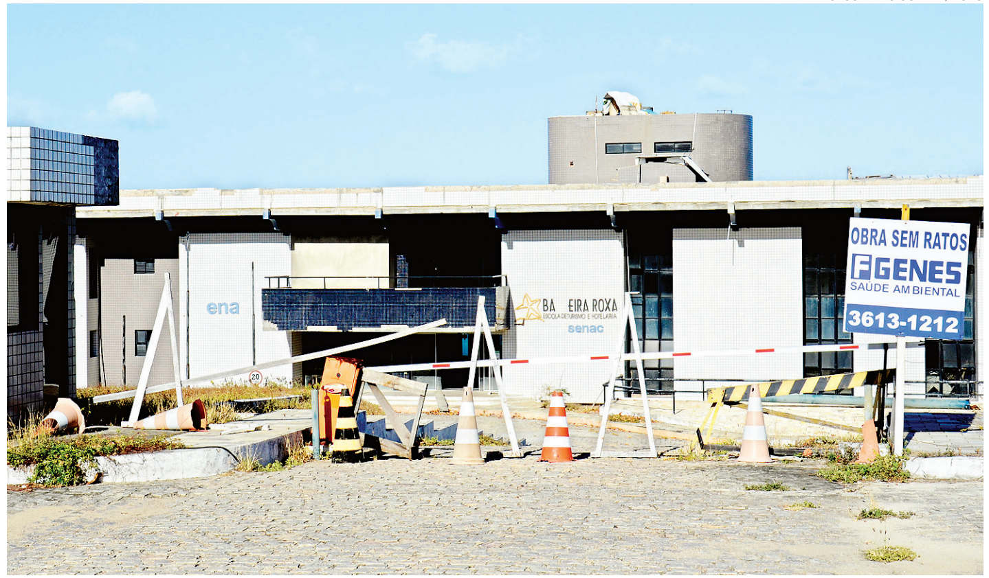
//Na parte da frente, cones e pedaços de madeira são usados juntos à cancela do hotel, cujo nome na parede já perdeu algumas letras...
