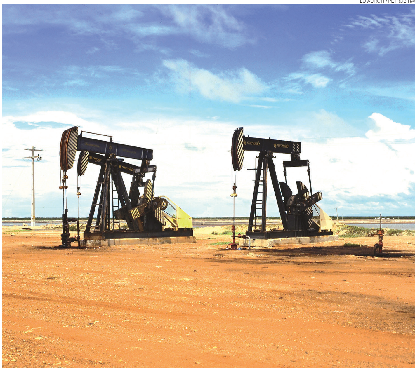
// Plano de venda de poços produção terrestre de da Petrobras deve afetar 1.500 trabalhadores do setor no Rio Grande do Norte
