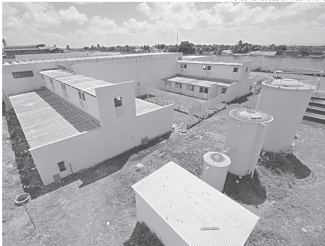
// Sete presos fugiram de Alcaçuz no fim de semana fazendo uso da tubulação de esgoto
