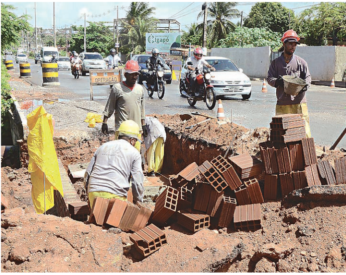
// Construção dos bueiros está em fase de finalização na Redinha
