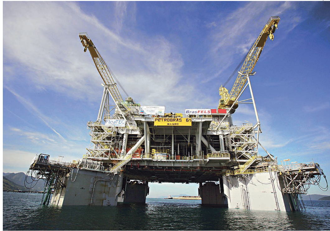
// Além dos poços maduros, Petrobras deve colocar à venda sete plataformas de produção no estado
