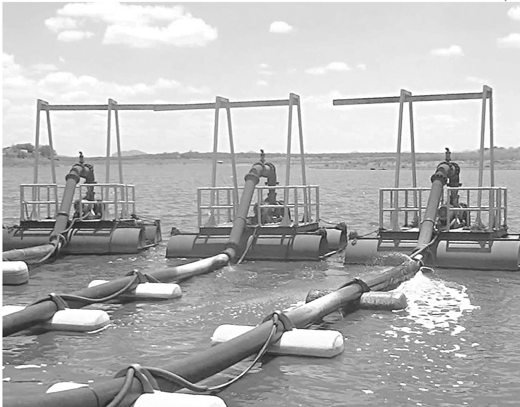
// Acidente aconteceu quando trabalhador fazia manutenção na barragem de Pau dos Ferros
