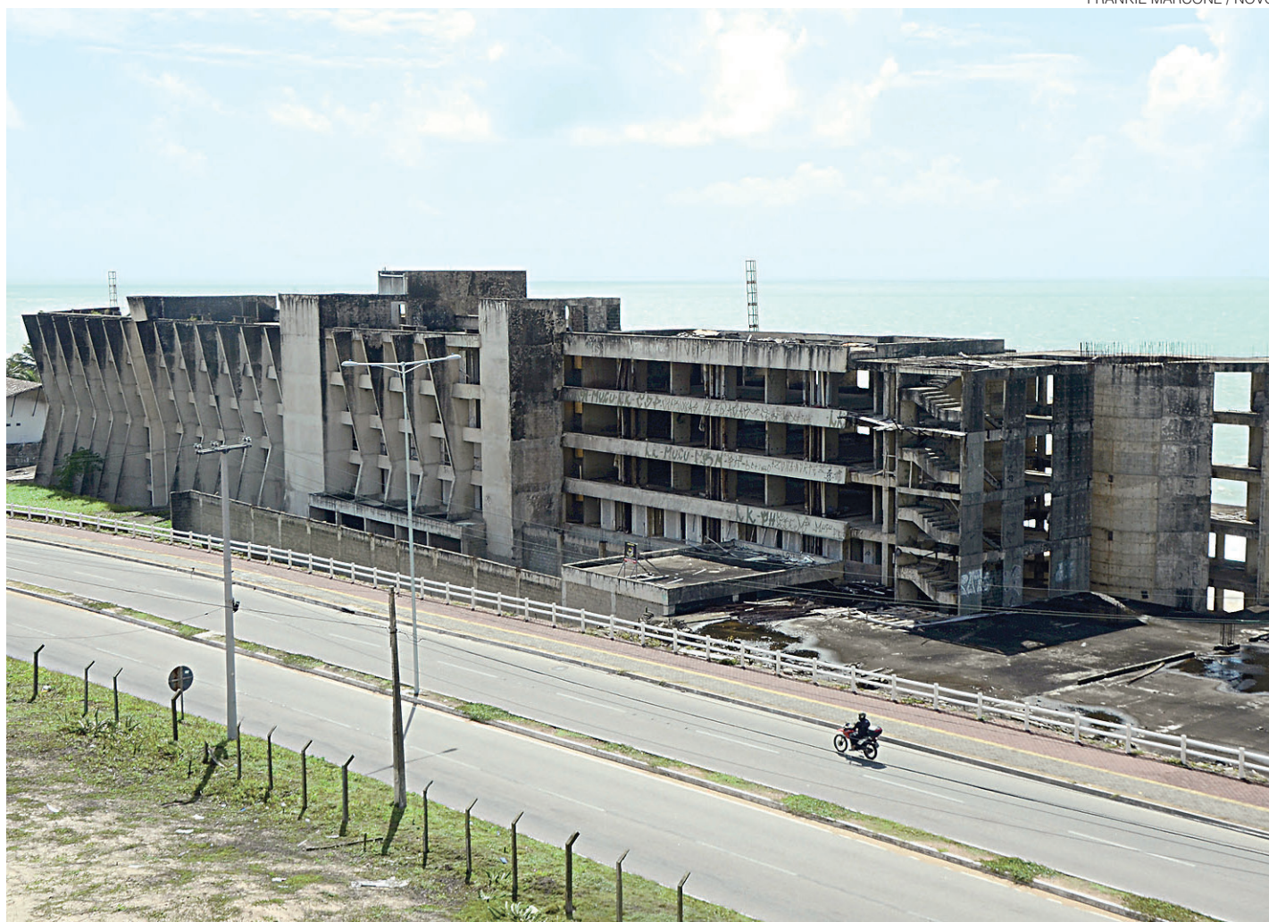
// Avaliação feita em 2014 pelo grupo proprietário, seriam necessários R$ 55 milhões para continuar a obra que já consumiu R$ 55 milhões
