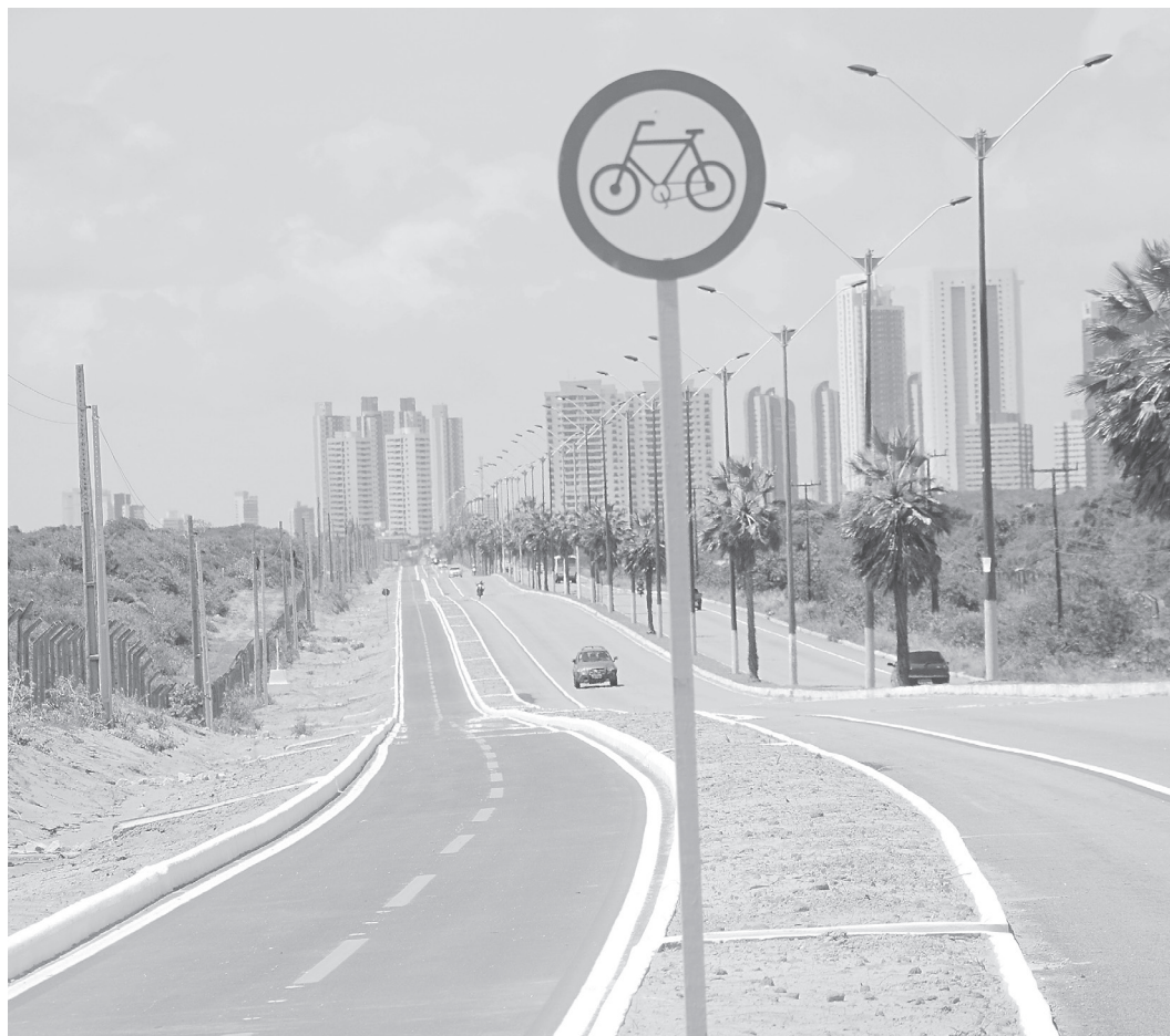
// Canteiro separa trecho, todo sinalizado, que será utilizado pelos usuários de bicicletas
