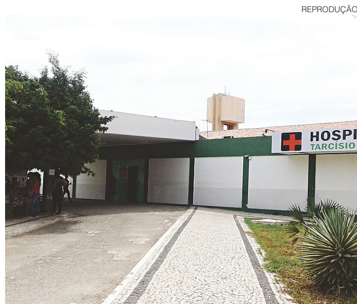
// Ampliação e reforma do hospital regional Tarcísio Maia, em Mossoró: mais de trinta anos sem conclusão
