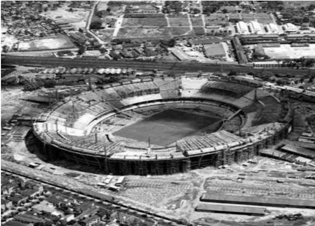
Figura 4 - Fotografia aérea do Estádio Municipal do Rio de Janeiro, na época de sua inauguração, início dos anos 1950.
